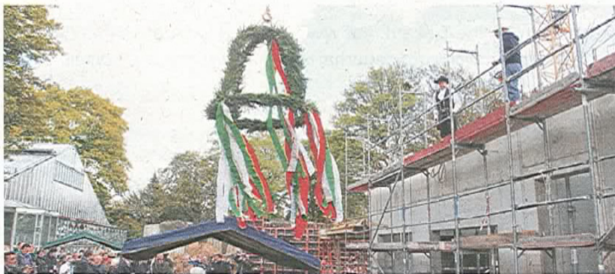
Mit dem Kran wurde der Richtkranz über dem neuen Gorilla-Haus im Zoo gestern hochgezogen. Das Außengelände grenzt an die Berliner Straße. RP-FOTO: LAMMERTZ
